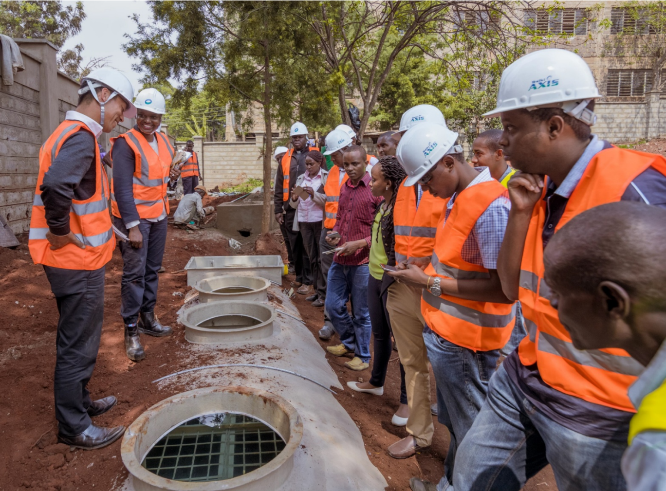
Introduction de Johkasou sur le site d'installation
